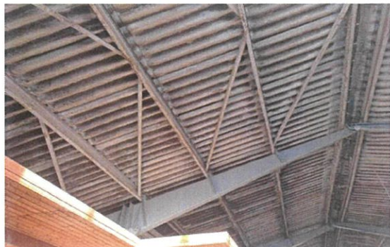
A főtartón rögzített szelemenek
