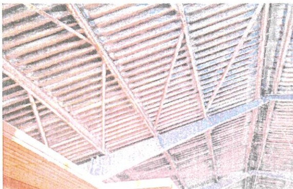
A főtartón rögzített szelemenek
