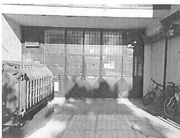
Radován téri hőközpont
