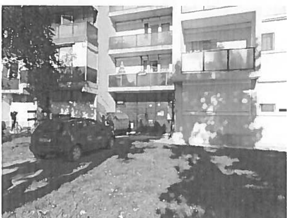
Radován téri hőközpont
