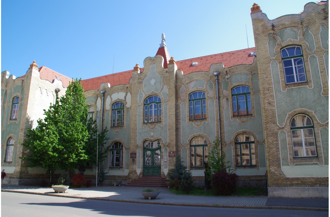
a gimnázium műemléki védelem alatt álló szecessziós épülete
