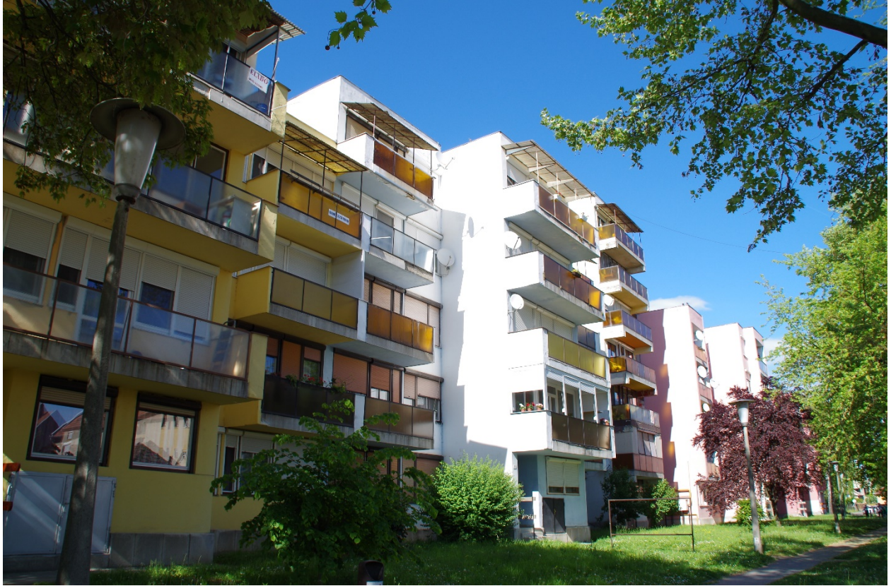
Radován téri épületegyüttes, tervezte Asbóth Gyula építész
