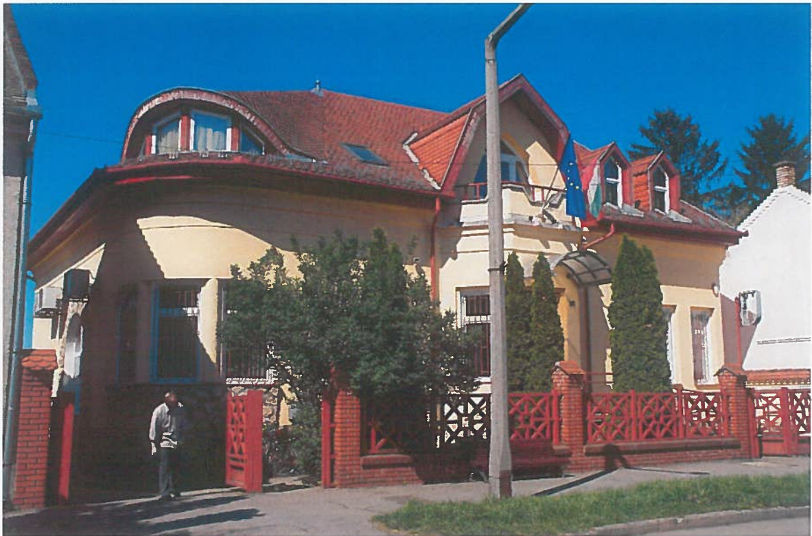
A kormányhivatal Rákóczi utcai épülete
