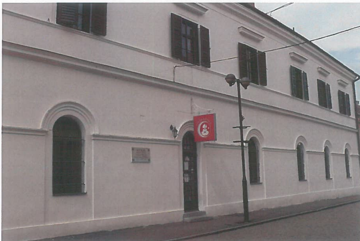
műemléki felújítás: Sós ház
